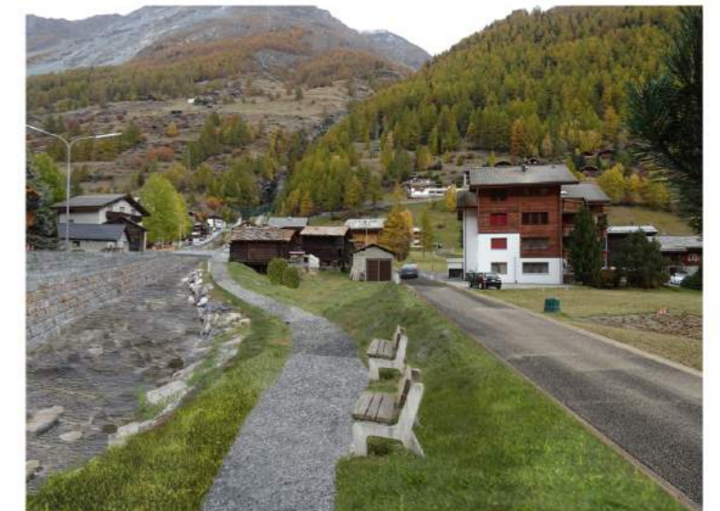
Abb. 4: Aufweitung und neue Erschliessung zwischen Dorfstrasse und Kantonsstrasse
